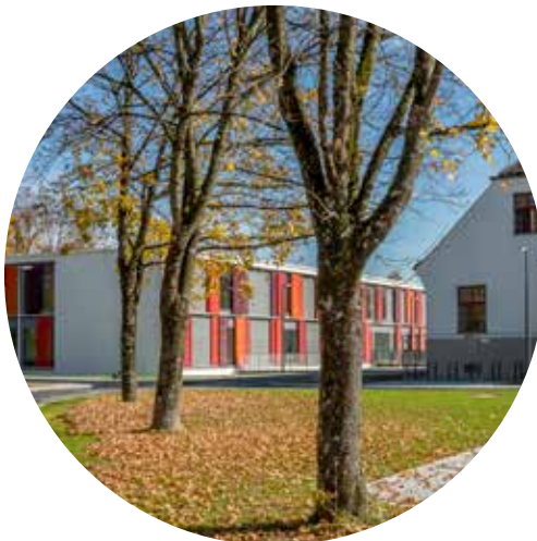
Eröffnung des zweiten Bauabschnitts Neubau Psychiatrie im kbo-Isar-Amper-Klinikum München-Ost
